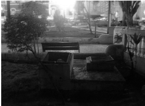
Figura 4 – Caixas de alvenaria.
