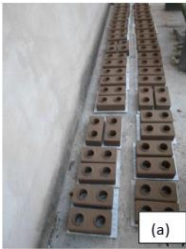
Figura 6 – Blocos na área de cura (a); lona preta cobrindo os blocos (b); molhagem dos blocos (c) empilhamento dos blocos após o período de cura (d).
