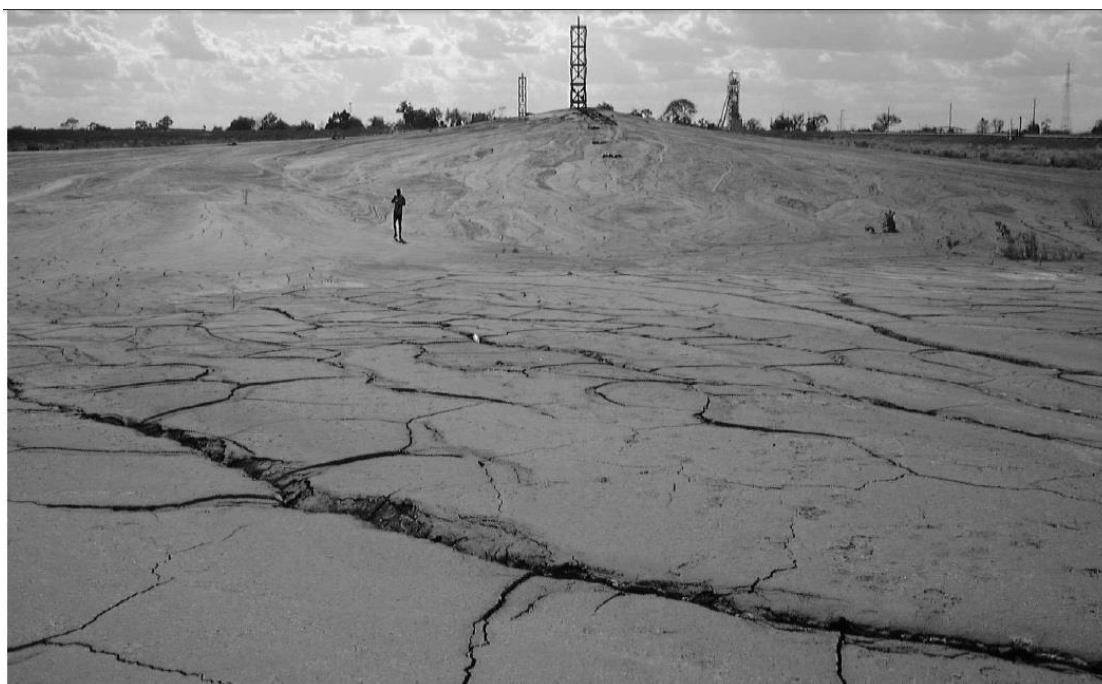
Figura 2 - Formação de cone sobre o rejeito depositado na Mina de Bulanhahu
