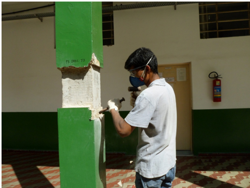
Figura 3 - Retirada do revestimento com talhadeira.
