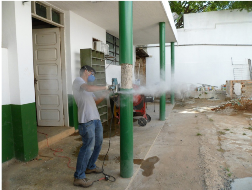
Figura 2 - Corte do revestimento com serra elétrica circular.
