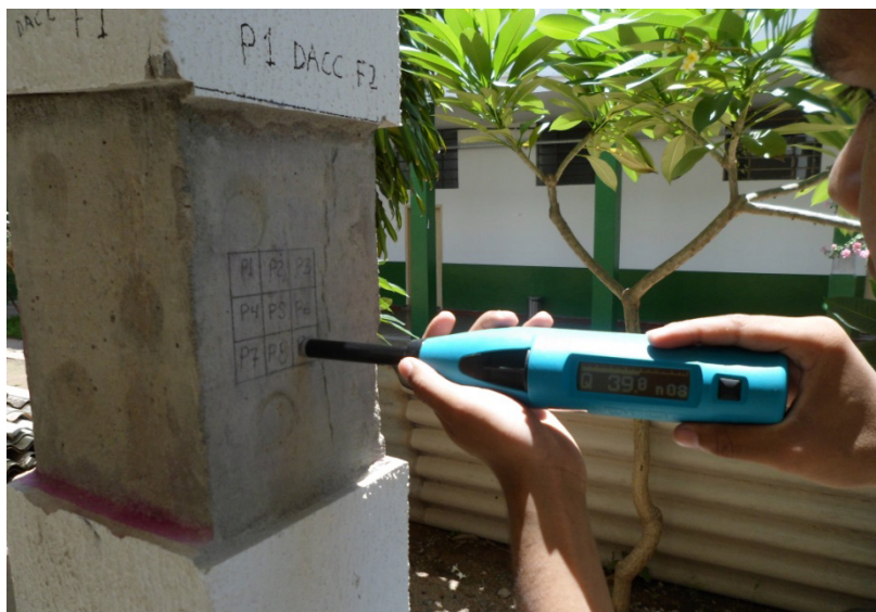
Figura 6 - Execução dos impactos contra a estrutura.
