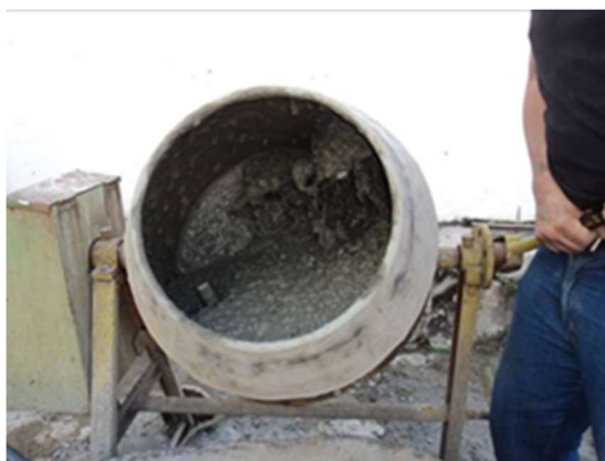
Figura 1 – Preparação do concreto
