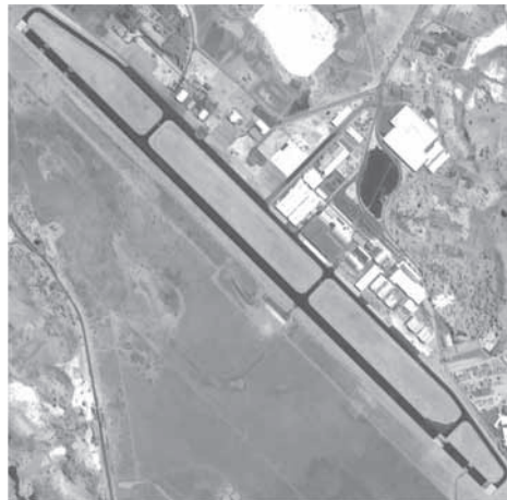
Figura 4. Abertura de Área para Eliminação de Faixas Brancas nas Pistas.
